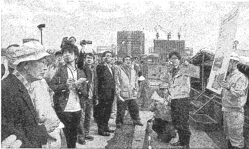
都民に公開した汚染土壌処理実験施設＝4月24日、東京都江東区
