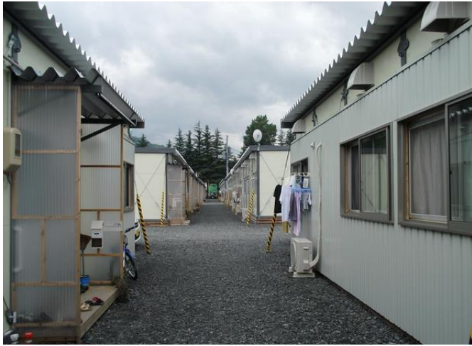
東日本大震災の仮設住宅
